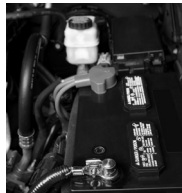
Batería sin corrosión
